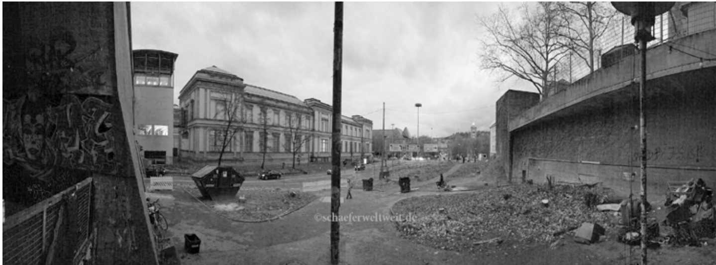
Bahn-Zerstörungen: Kahlschlagzone vor dem Wagenburgtunnel am Tag nach der Fällung von 30 Bäumen (Foto: Alexander Schäfer)
